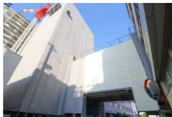
2023年10月24日 上空通路西側より撮影
