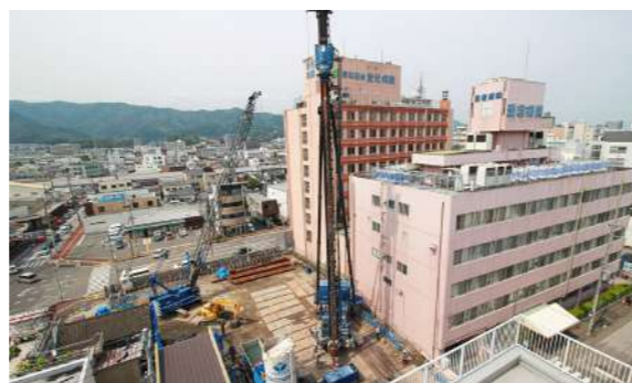
基礎工事の様子 2022年6月 南館8階より撮影
