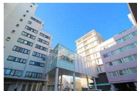
上空通路(南館ロータリーから撮影)
